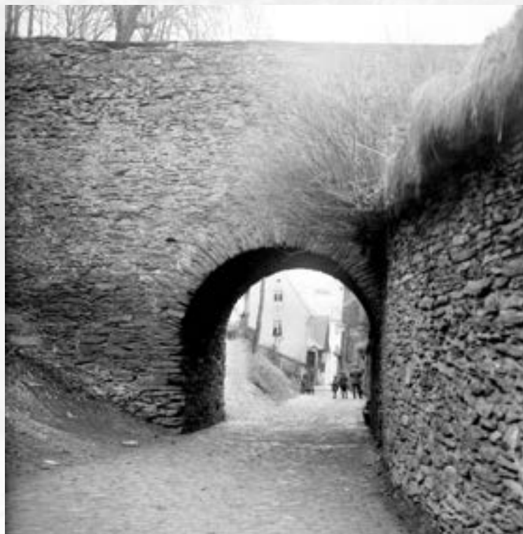
Průhled mostem na Příkopech, r. 1929
